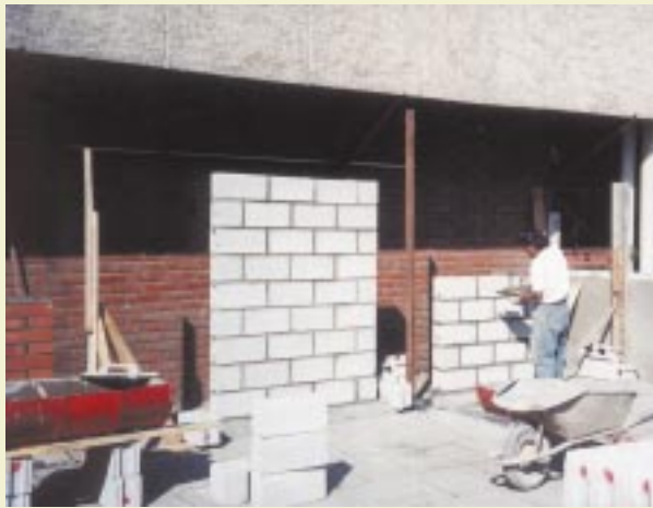
Fotografía 3.- Construcción de uno de los muros de ensayo.
