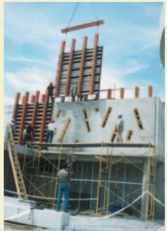
Hormigón arquitectónico. Construcción de muro con hormigón autocompactante
