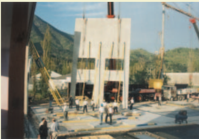
Muestra a escala real de muro de hormigón con sistema Tilt-Up: construcción, izaje y apuntalamiento
