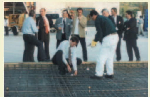
Protección contra corrosión de armaduras
