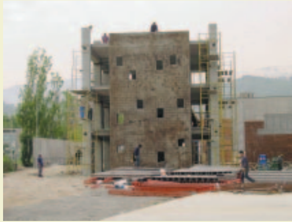
Construcción de edificio prefabricado de 3 pisos: montaje de vigas y sistema de uniones
