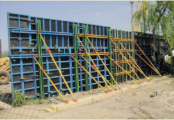
Construcción de muro de 40 metros para medir tolerancias
