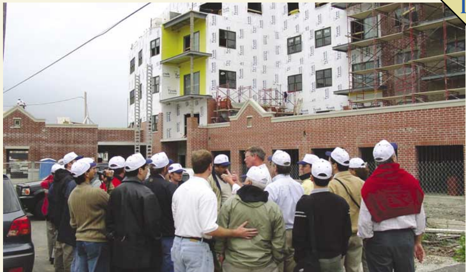
En esta visita se pudo apreciar la construcción de un conjunto de edificios de 4 pisos destinados a uso mixto, comercial y residencial. La construcción típica de Chicago es con doble muro, en el cual el muro exterior es de ladrillo a la vista y el muro interior es de bloques de hormigón con relleno completo de huecos.
