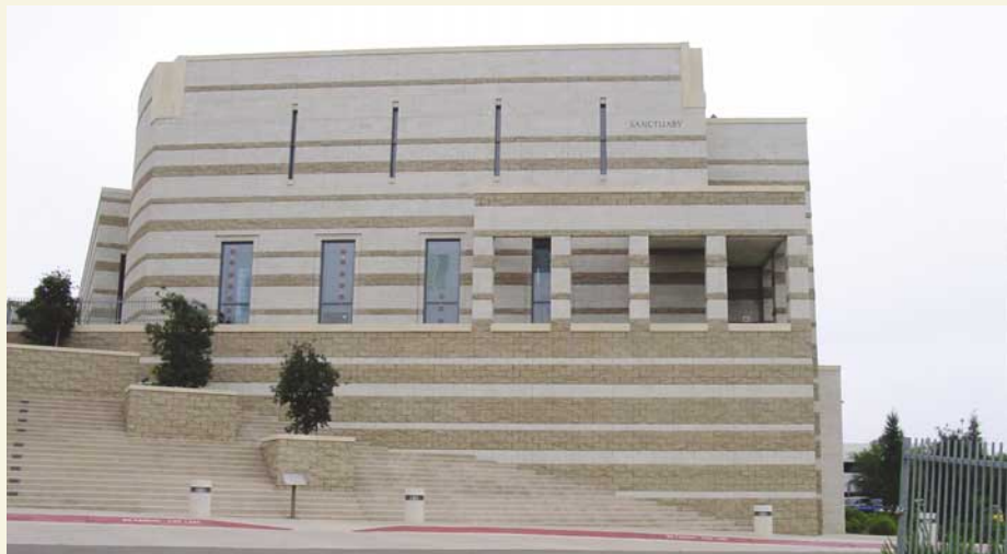
Visita a la sinagoga Beth Israel que ha recibido numerosos premios tanto en EE.UU como en otros países por la calidad de su diseño y construcción. Corresponde a una estructura construida completamente con bloques de hormigón, en el que se mezclan diferentes texturas y colores.
